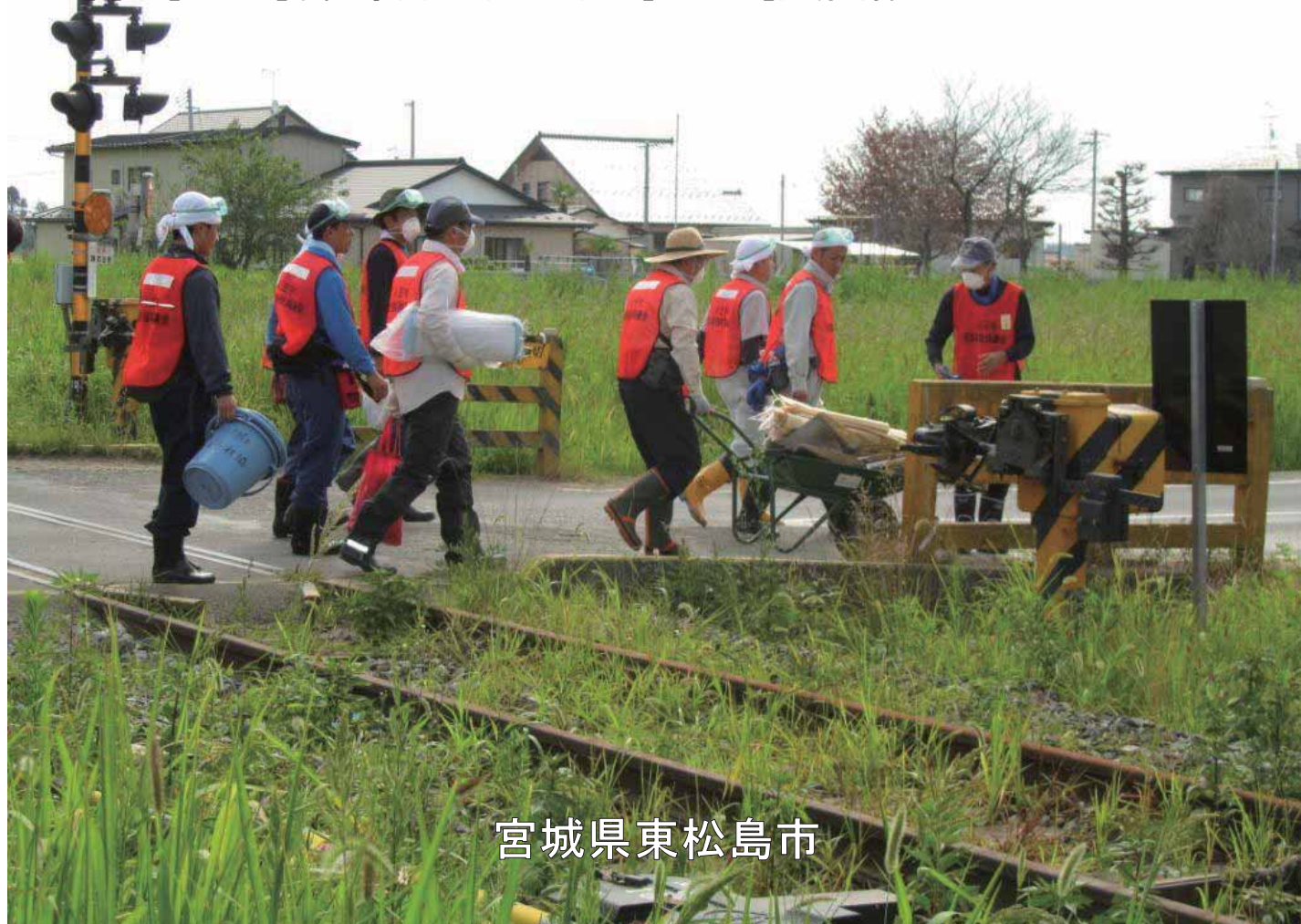
2405_4_029_036926_東松島市社会福祉協議会_2011.8.6_側溝清掃作業
